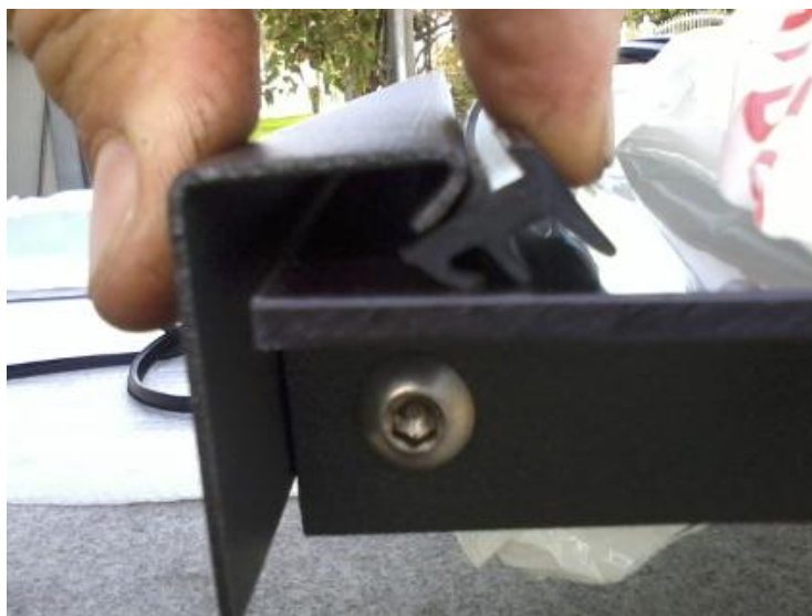
Figura 10: Inserimento guarnizione di fissaggio a muro.
