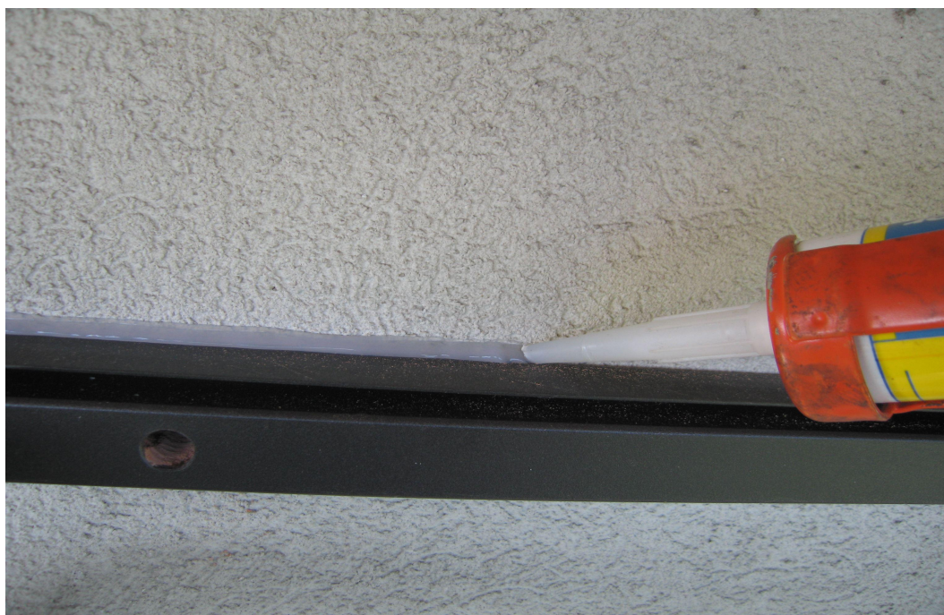
Figura 6: Sigillatura del profilo a muro.
