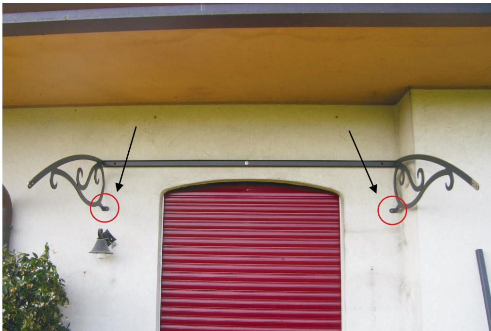
Figura 5: Fissaggio a muro della staffa laterale.
