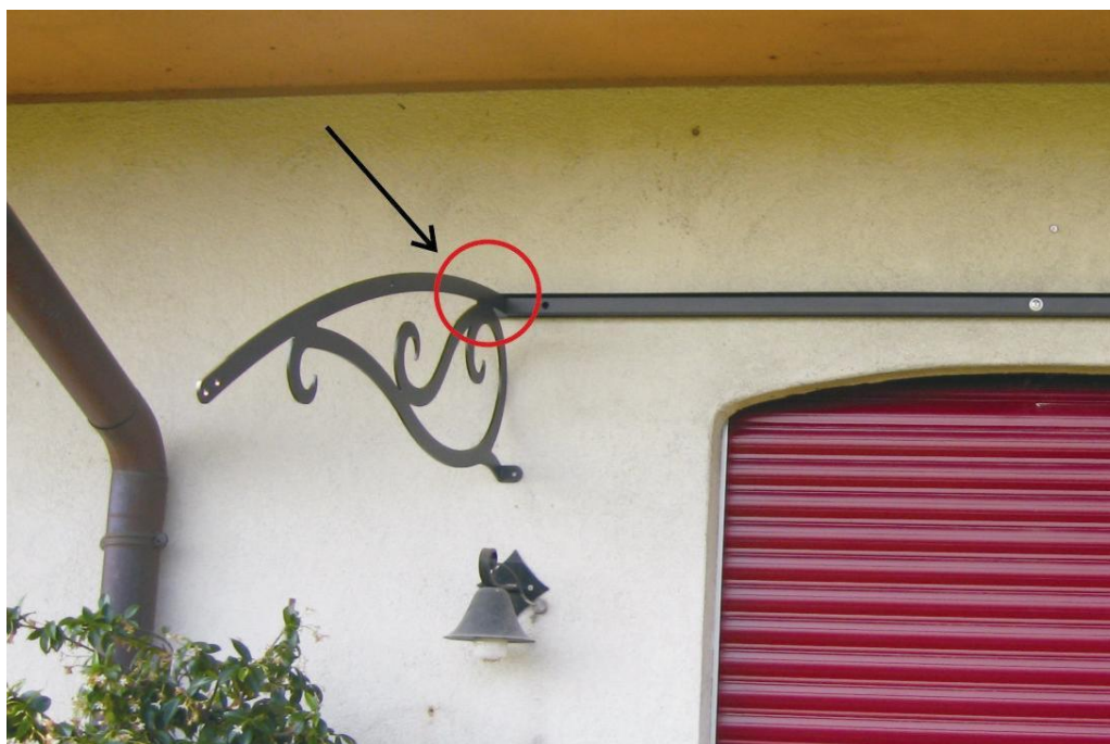
Figura 4: Applicazione delle staffe laterali al profilo a muro.
