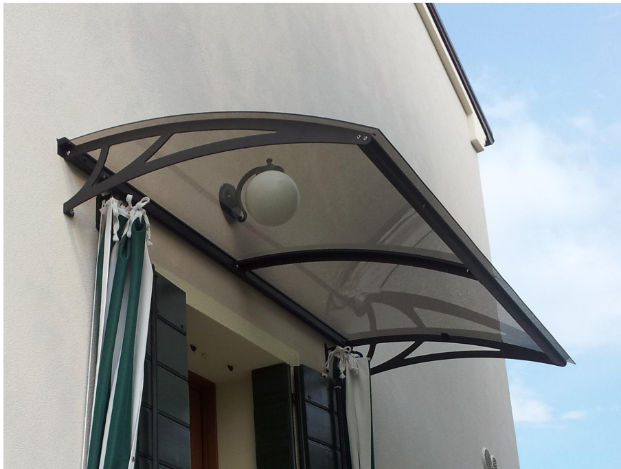
Figura 11: Rimozione della pellicola di protezione e fine installazione.
