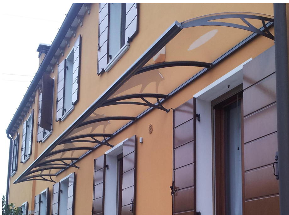
Figura 8: Esempio di pensilina con staffe intermedie portanti e non disposte alternate.
