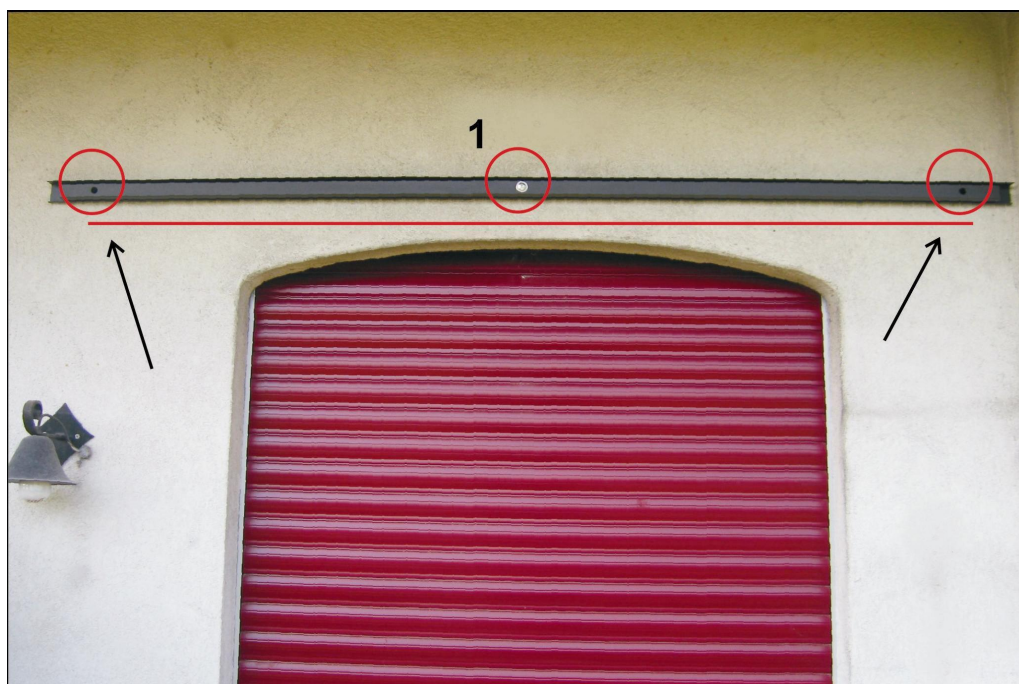
Figura 3: Fissaggio a muro e verifica della posizione orizzontale del profilo
